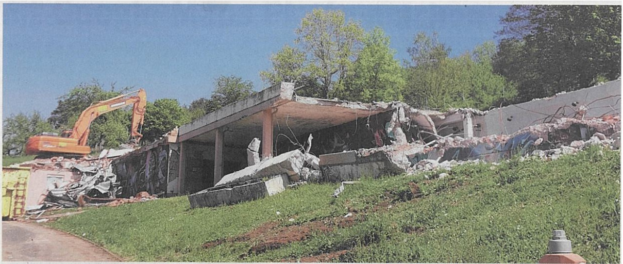
Im Frühjahr wurde das alte Mömlinger Hallenbad abgerissen – es wird durch einen Neubau mit 25-Meter-Becken ersetzt. Kostenpunkt: 5,6 Millionen Euro. Foto: Siegfried Scholtka
